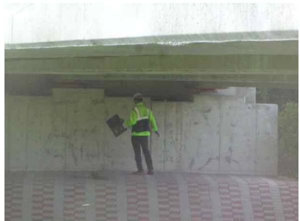
도보를 이용한 근접조사
