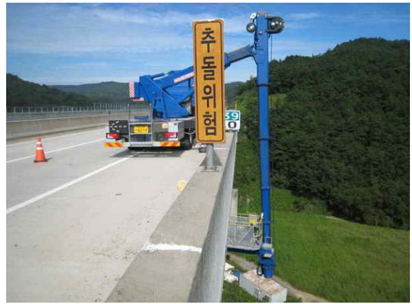
굴절점검차를 이용한 근접조사
